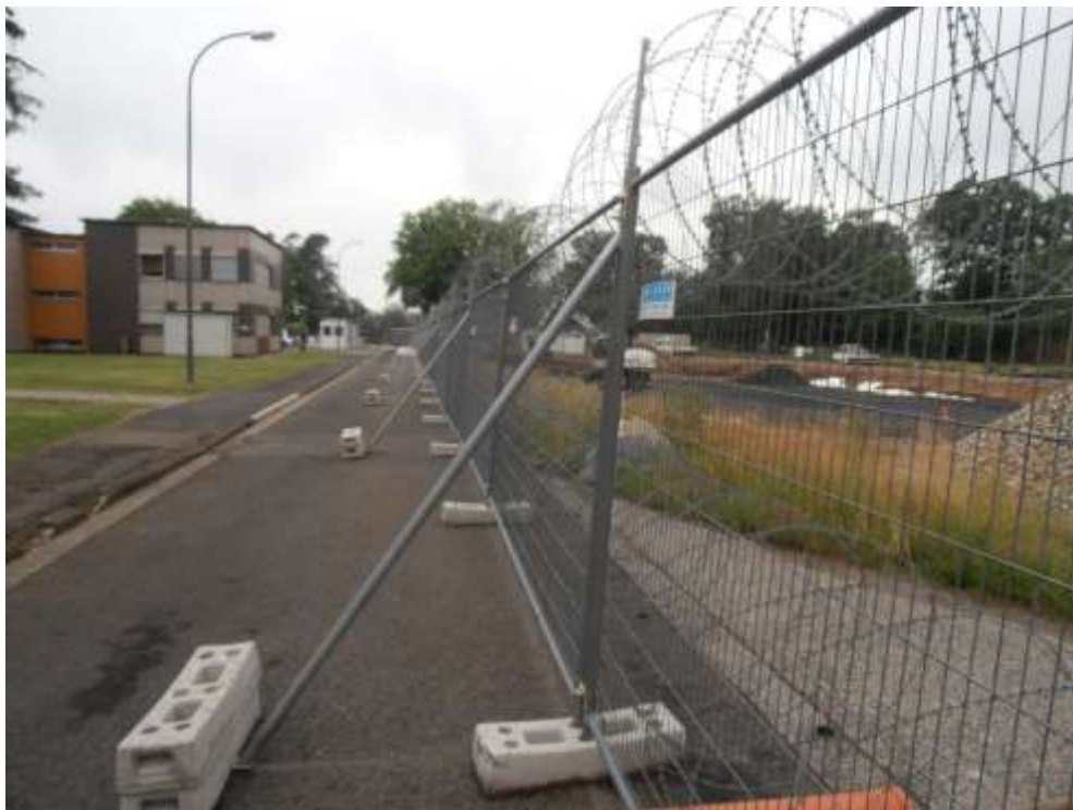
...Blick von der Baustelleneinfahrt auf den alten SAN-Bereich.
