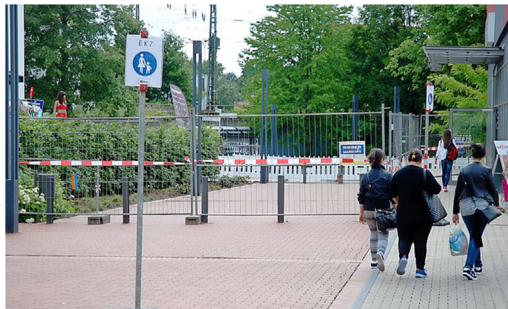
Derzeit versperren Baustellenzäune den direkten Durchgang durch die Bahnunterführung in der Stadtmitte.
