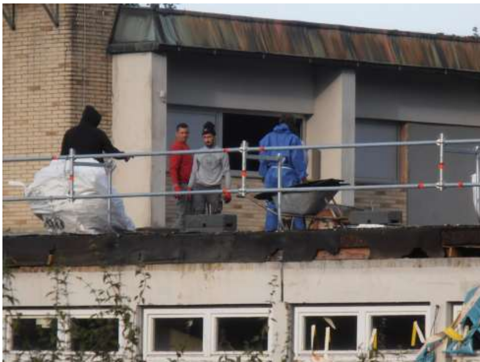
...die Arbeiter in Schutzanzügen die zum entsorgen der Teerpappe eingesetzt sind
